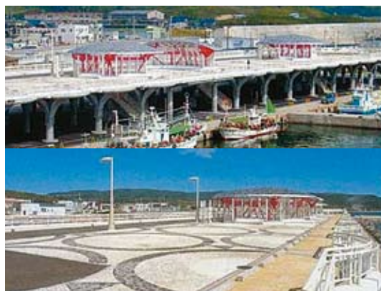
図18 人工地盤(奥尻島の奥尻町青苗地区)
