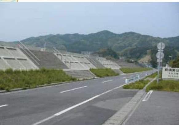
図13-a 田老町の津波防潮堤(高さ10m、全長2433m) [1934-1988]
