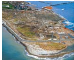
図10 奥尻島青苗地区の北海道南西沖地震津波による被災(1993年)
