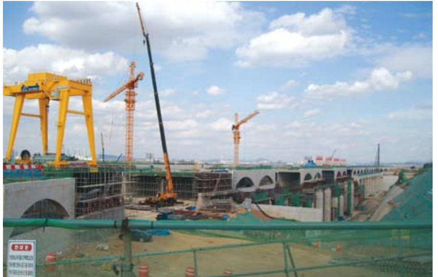
写真6 潮力発電所の建設現場
