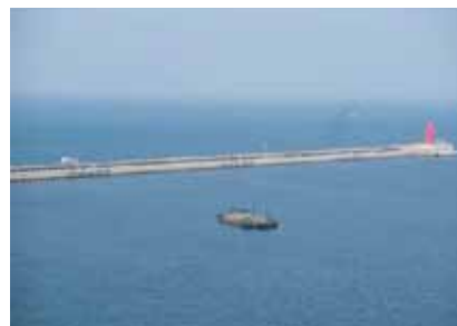
写真3 新ターミナル沖合防波堤
