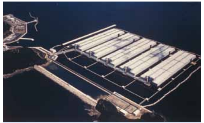
写真3 上五島石油備蓄基地
