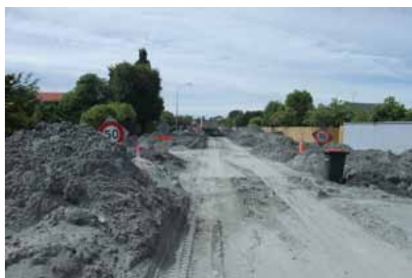
写真2 クライストチャーチにおいて2月の余震で発生した多量の噴砂
