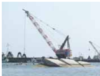
写真18 防波堤消波ブロック移設状況
