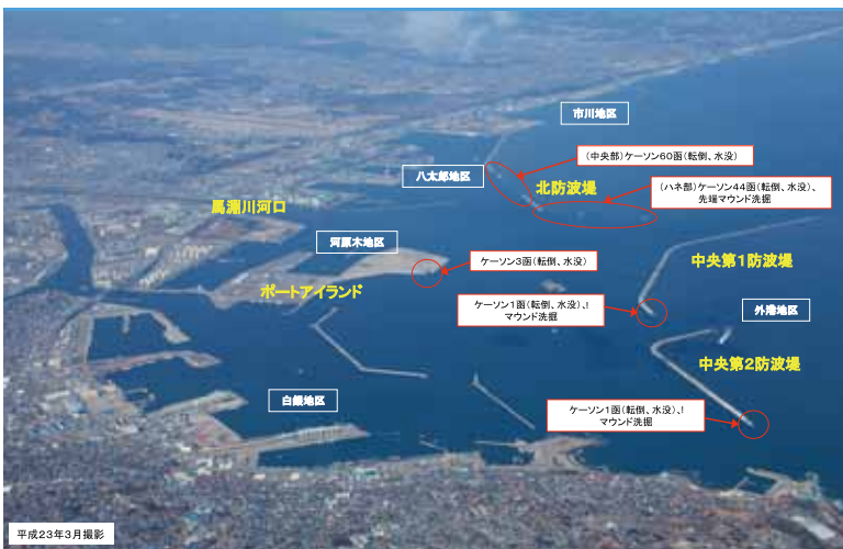
写真13 八戸港被災状況(港内全域)
