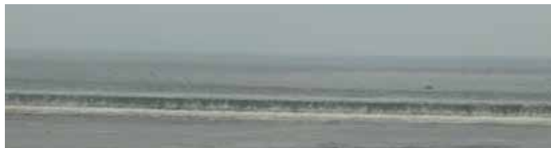
写真15 16:35頃の北防波堤中央部の状況
