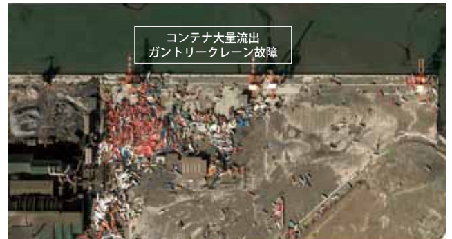
写真1 仙台塩釜港仙台港区高砂埠頭
