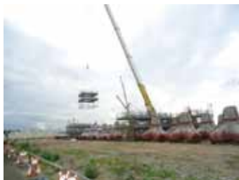
写真20 消波ブロック製作状況
