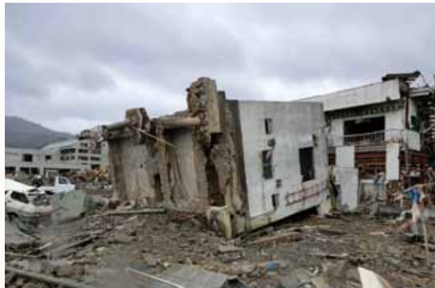
宮城県女川町での被災したコンクリート建物
