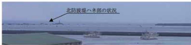
写真16 津波初期段階での北防波堤ハネ部被災状況
