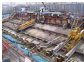
写真4 仮囲い内での小口径推進削孔状況
