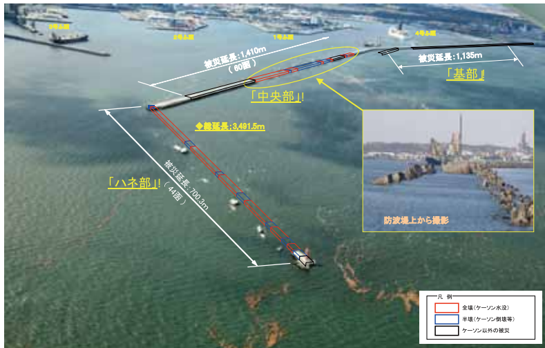
写真14 八戸港北防波堤被災状況
