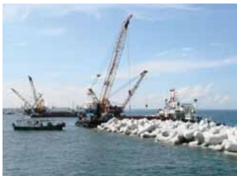
写真17 北防波堤消波ブロック据付状況
