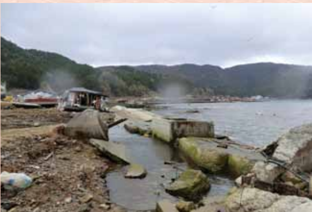
宮城県石巻市雄勝での沿岸保全施設の被災状況
