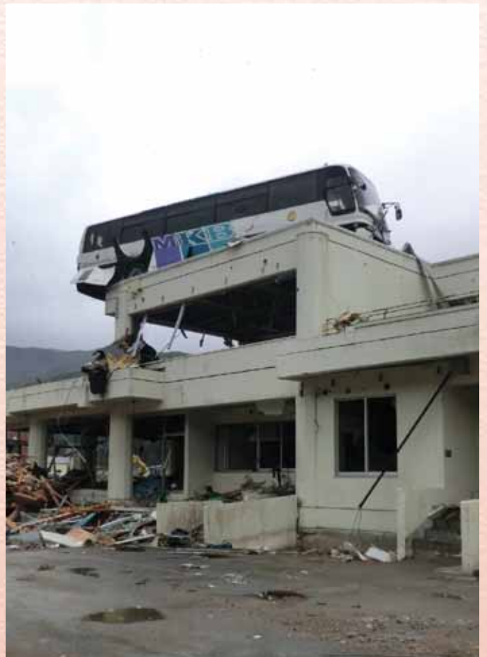
宮城県石巻市雄勝での津波により移動した大型バス
