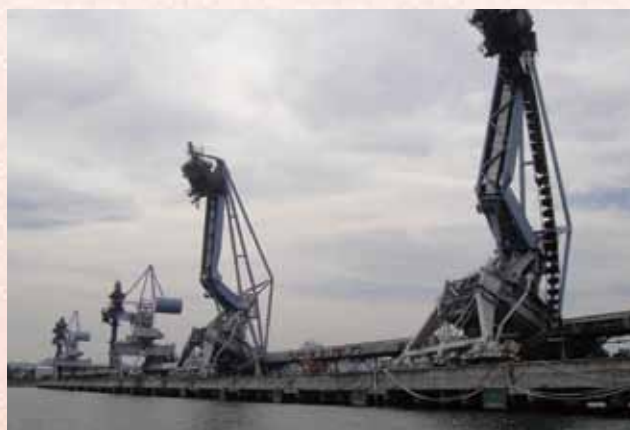
被災した荷役設備
