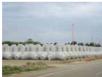
写真19 消波ブロック仮置き状況
