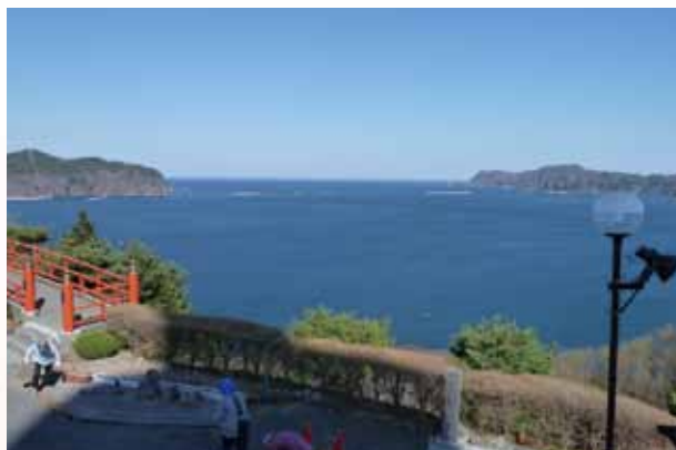
釜石湾口防波堤を遠くに見る。被災したものの、湾内の津波高を減少させるという効果を発揮した。
