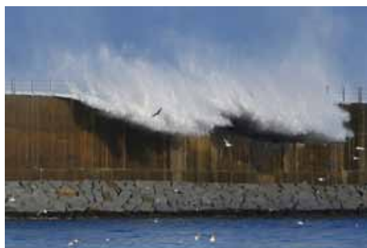
写真3 2008年2月24日江陵・安木港防波堤でのうねり性波浪による越波
