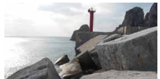
写真2 2011年8月7日9号台風ムイファアの来襲により破壊された可居島防波堤
