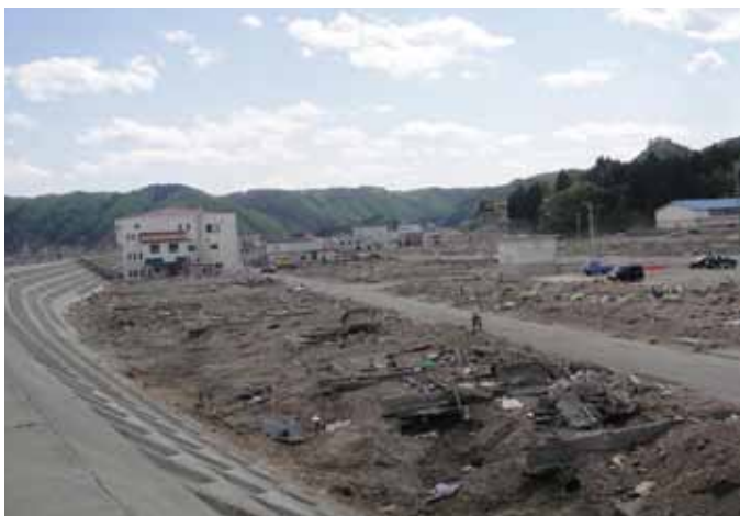
写真7 津波防波堤背後の家屋の被災状況
