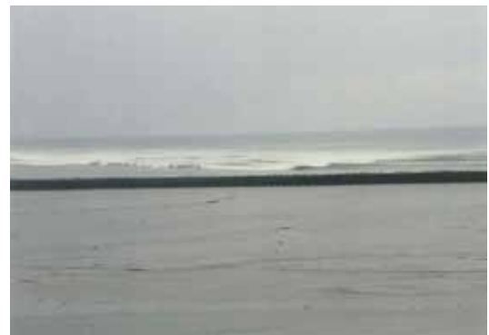
写真4 八戸港北防波堤に來襲してくる津波第2波 2011年3月11日16:24
