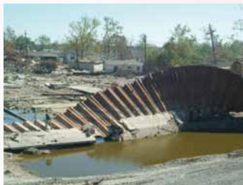
2005年のハリケーンカトリナの現地共同調査 (写真は崩壊した運河堤防)
