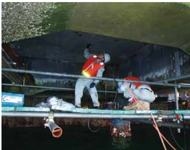
写真2 吊り足場からの近接目視調査
