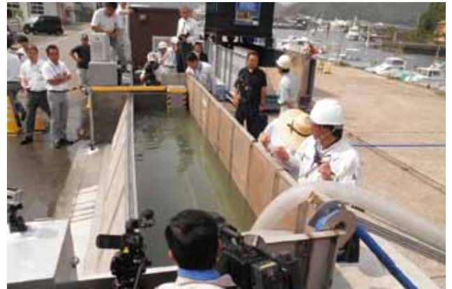
写真6 自動閉鎖確認状況
