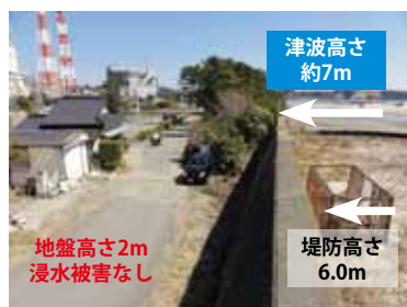
図2 福島県勿来海岸における津波浸水被害の軽減事例
