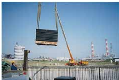
パレットで搬入されるケーソンラバー
