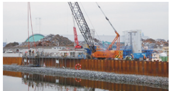
写真2 HCB-Fの打設状況
