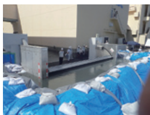
起立状態(現地水張試験により津波来襲時を模擬)
