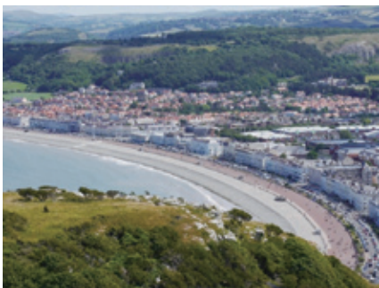
写真2 ランディドノ海岸に沿った防潮堤と遊歩道
