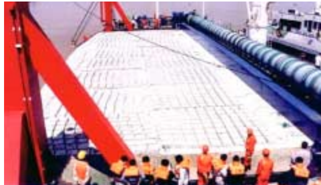
写真 4 マット敷き作業船
