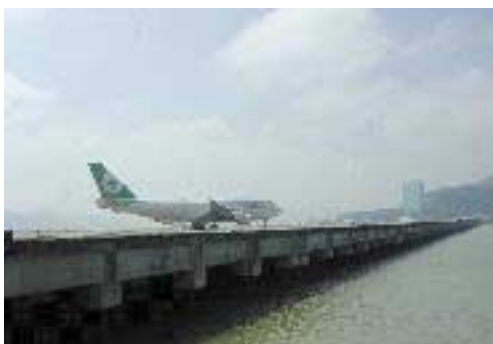
マカオ国際空港の誘導路
