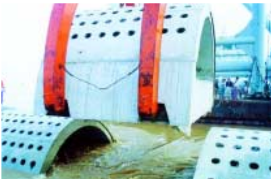
写真 3 南導堤(半円堤) Closingの瞬間
