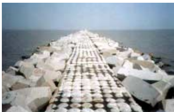
写真 2 北導堤(傾斜堤)
