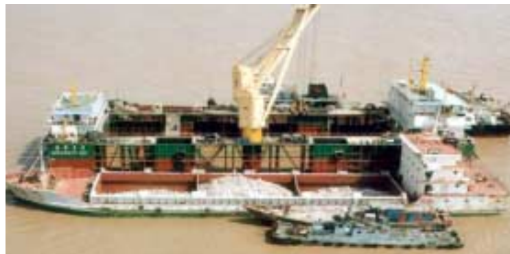
写真 5 着底式捨石均し船（上：捨石均し船、下：石運搬船）
