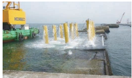
図13 止水蓋によるケーソンの再浮上(相馬港)
