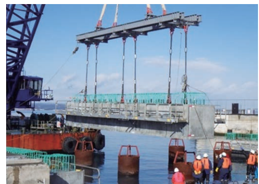
図10 剛結構造を有する棧橋受梁の施工例(青森港)
