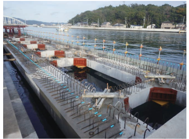
図9 棧橋上部工のプレキャスト例(渡波漁港)
