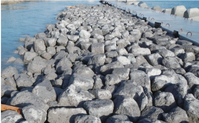
図11 人工石材の適用例(裏込石)
