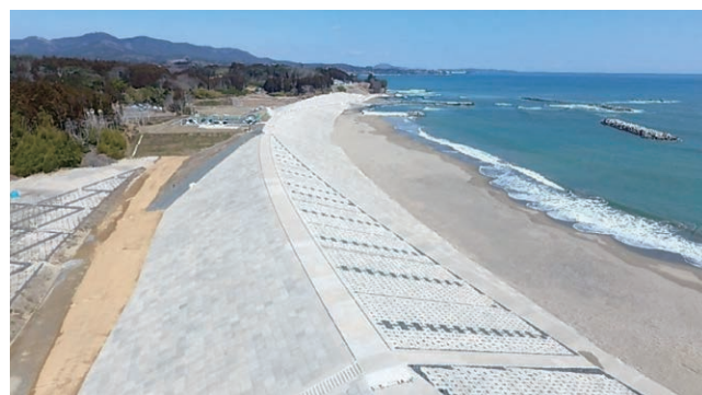
図6 ブロックで被覆された防潮堤(中島海岸)
