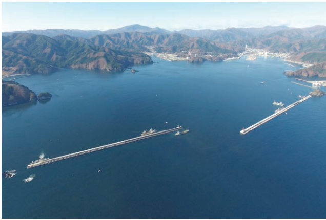
復旧工事で蘇った釜石湾湾口防波堤
