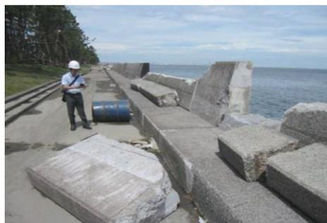
図-1 横浜港における高波による護岸倒壊事例
