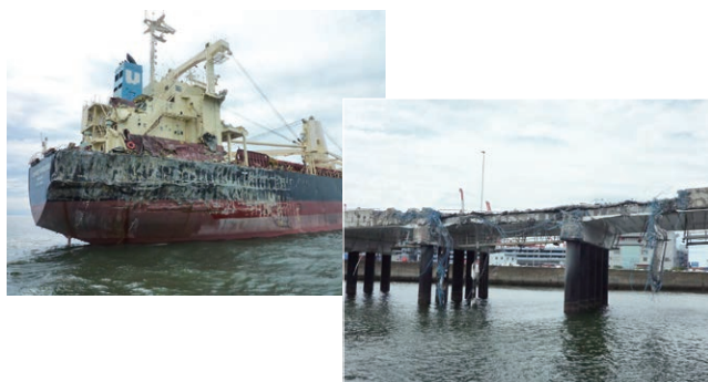
図1 横浜港南本牧地区のはま道路（橋梁）への貨物船の走錨・衝突 1)
