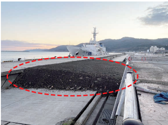
写真1 応急復旧で使用性を確保した岸壁 (輪島港(2024年1月))
