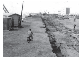
山の下ふ頭背後の地割れ
