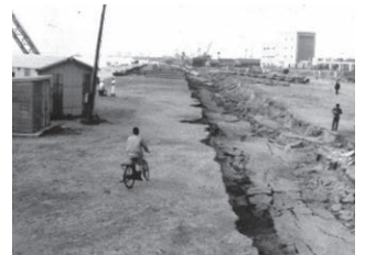
山の下ふ頭背後の地割れ
