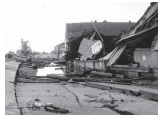
北ふ頭物揚場と上屋の損壊
