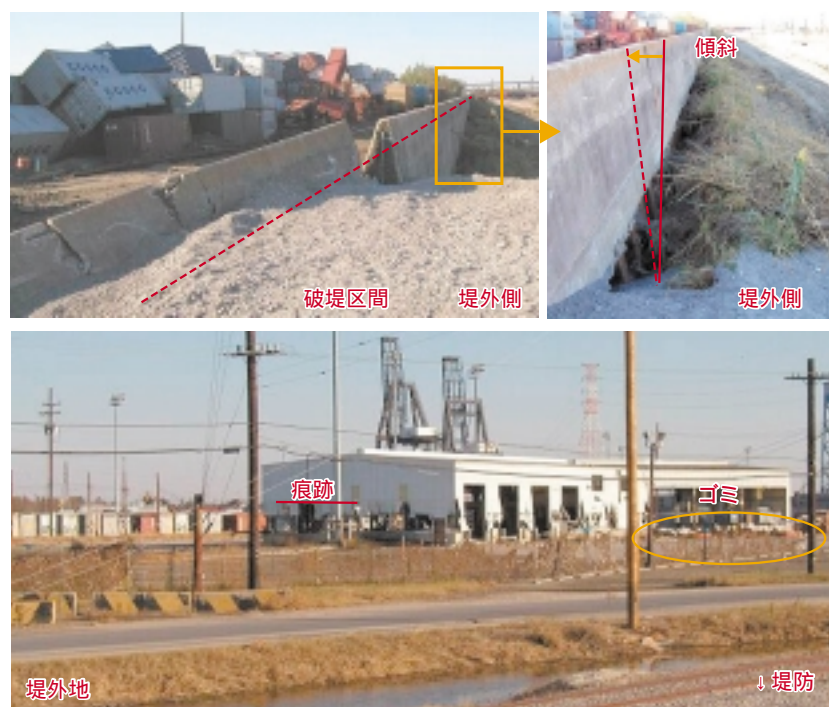
(c) 図9の地点⑥ 写真-4 Inner Harbor Navigation Canalの破堤地点の状況 (続き)
