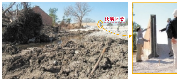
(a) 破堤区間と堤防の断面
