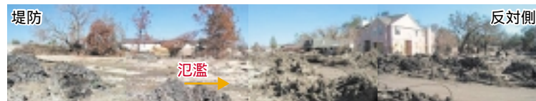
(b) 氾濫による土砂の移動と家屋の破壊
