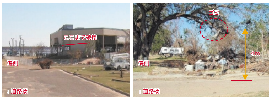
写真-11 ビロキシの道路橋付近の建物の被害と漂着物
