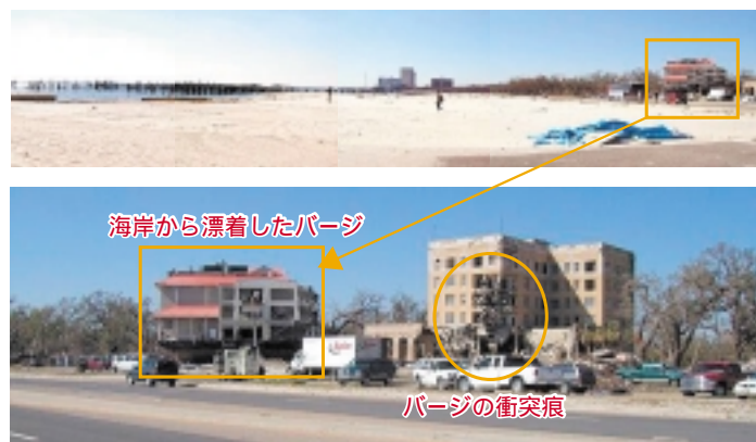
写真-9 ピロキシのカジノ・バージの打ち上げと建物への衝突
